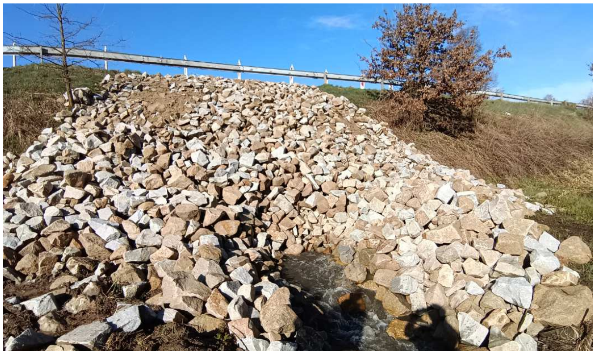
Foto4: Stabilizace hráze za pomoci hrubozrnného kameniva
